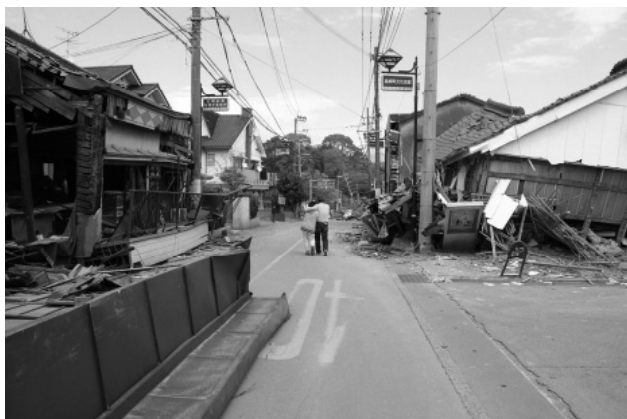
【写真1-1】本震直後の益城町 （熊本地震デジタルアーカイブ、提供者：益城町）
